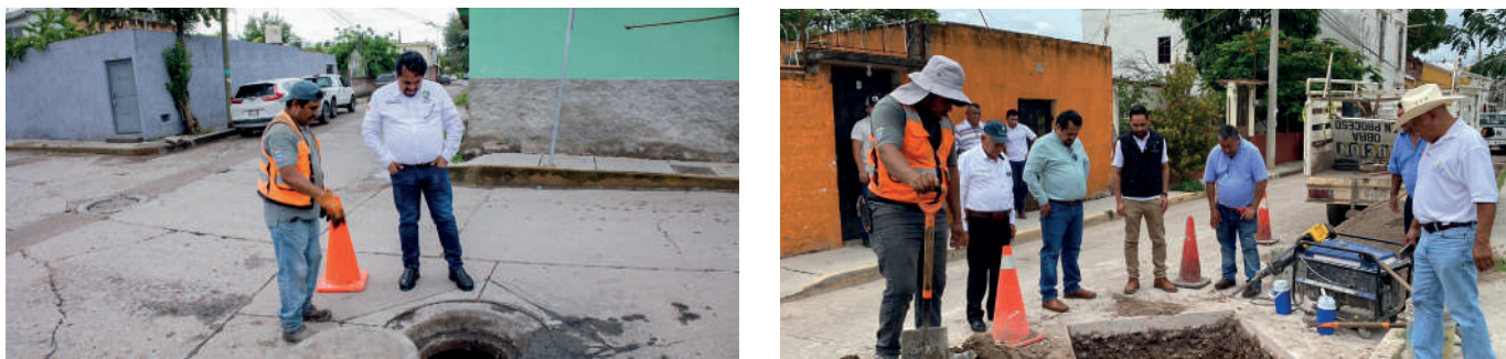
Trabajos de rehabilitación de la línea de drenaje pluvial en Ciudad Fernández, la cual había permanecido sin funcionar durante más de ocho años.
