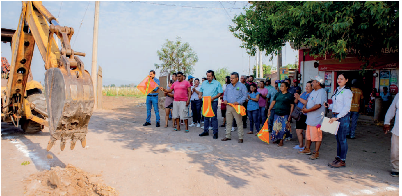
Se realizó la ampliación de 230 metros lineales de red de agua potable con tubería de PVC HCO RD-26 de dos pulgadas, en la calle San Martín y privada El Recodo, en El Refugio.
