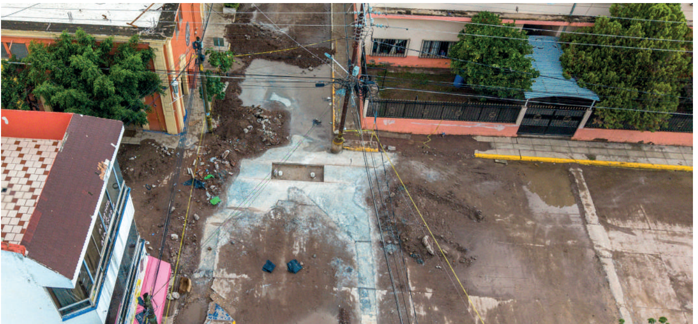
Rehabilitación de la línea de distribución de agua potable en la Zona Centro de Ciudad Fernández.
