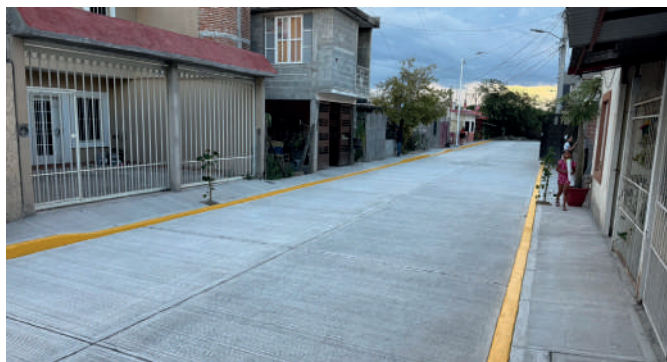
Construcción integral de pavimento con concreto hidráulico en la calle Anáhuac.
