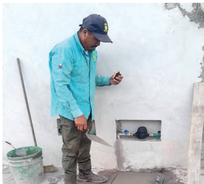
Reubicación de 160 cuadros de medidor hacia el exterior de los inmuebles.
