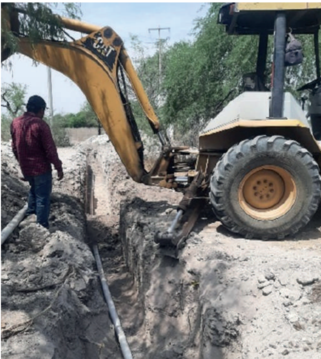
Interconexión de la línea primaria de 6 pulgadas en el sector norte de las colonias de Fertimex.
