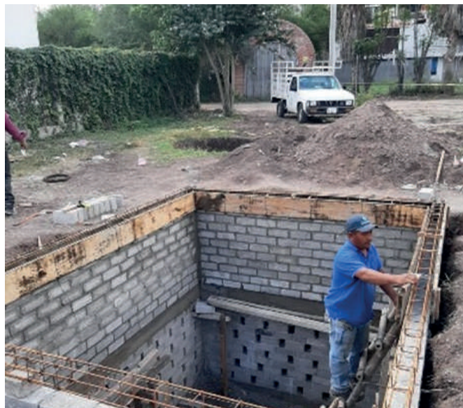
Se llevó a cabo la colocación de 2 biodigestores al norte de la calle Martínez
